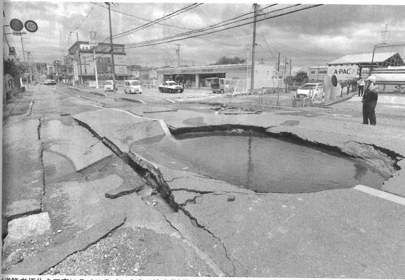
水道管老朽化を口実にライフラインを売り渡す（地震で水道管が破裂し陥没した道路、大阪府高槻市、6月18日）
